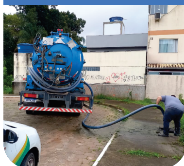
Limpeza de Bueiros
