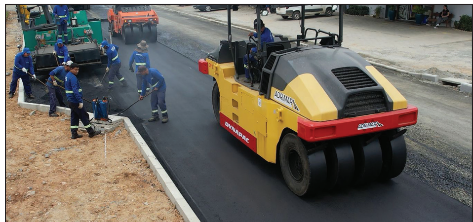
Obras na Avenida Maria Marangoni
